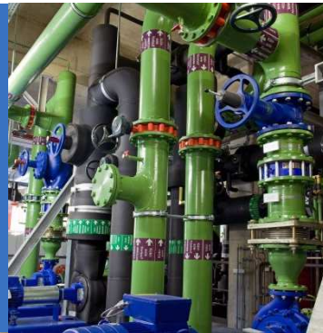
Anschluss Rückkühlwerk
